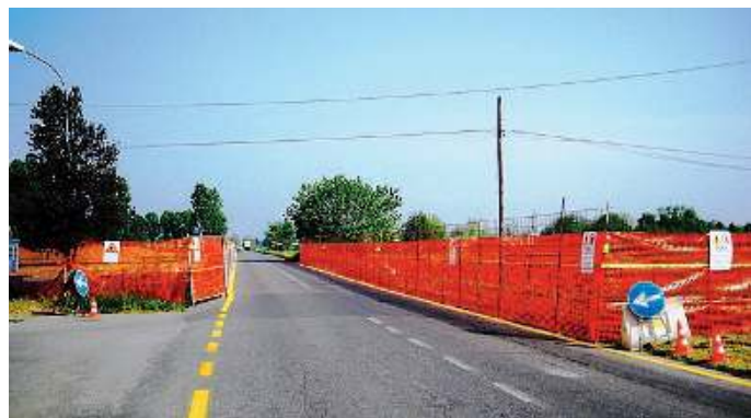
Il cantiere. La strettoia sulla Sp VII per consentire lo sbancamento
